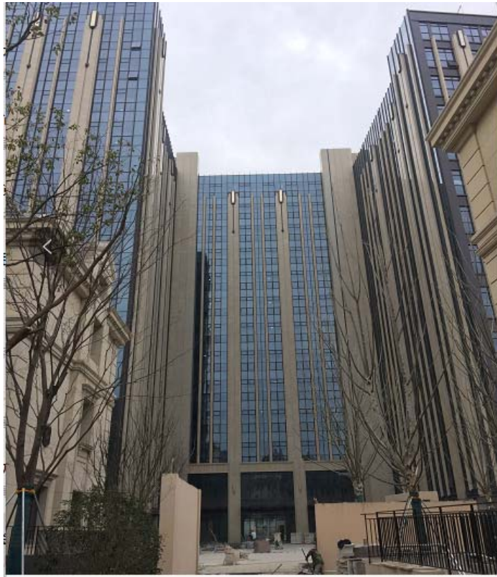
项目建筑物现状
