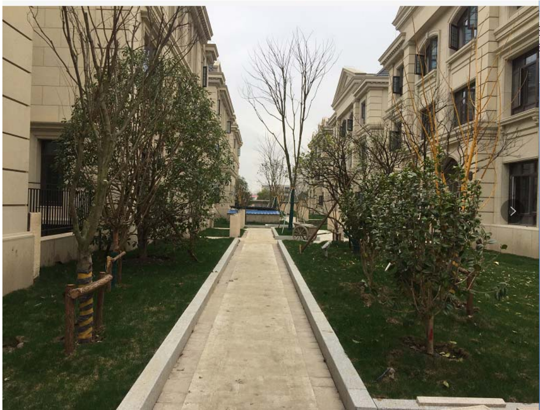
项目建筑物及景观绿化现状
